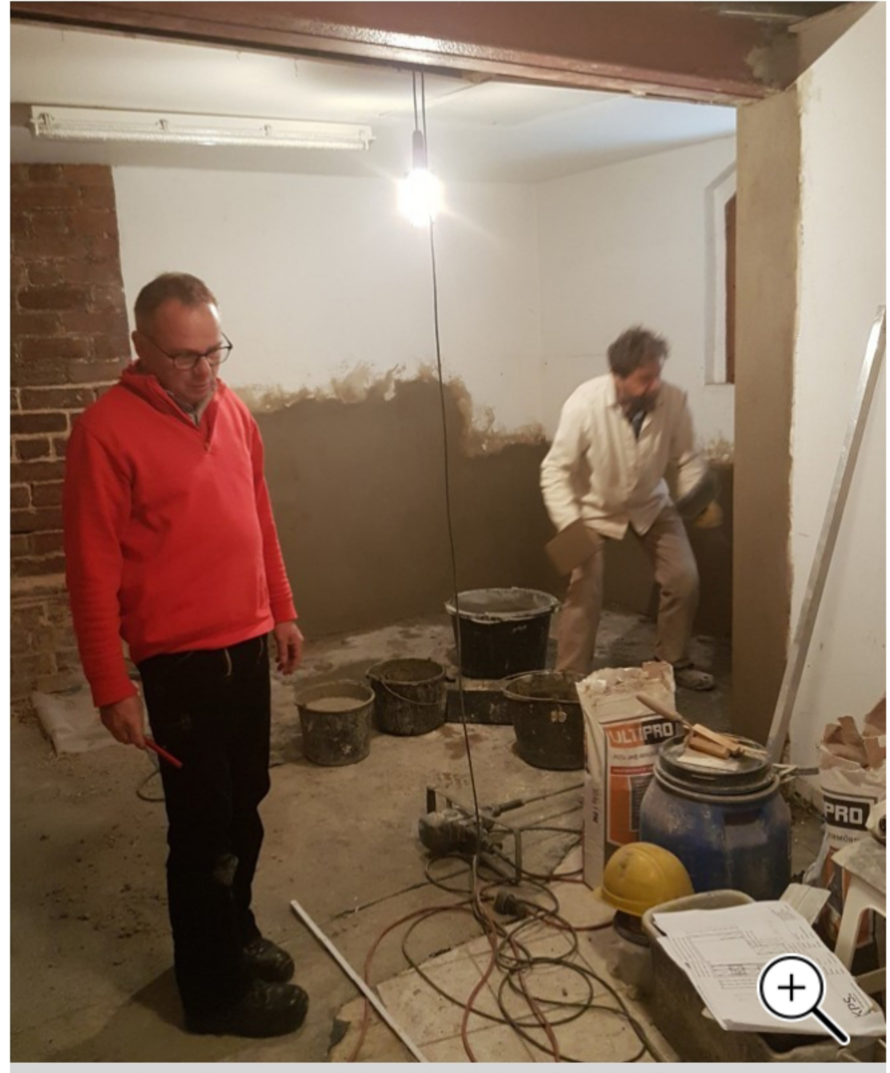
Zimmerer Marco Vack (l.) und Maurer Helmut Hellriegel bei den Umbauarbeiten in der Küche von St. Marien. Foto: B. Hornemann
