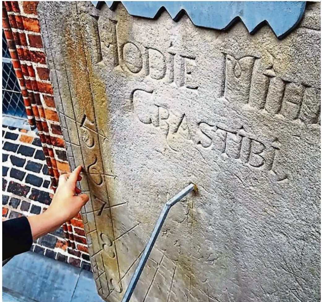
Als die Restauration an der Sandsteinplatte zehn Meter über dem Südtor im Juni begann, galt es, Verfärbungen und Bewuchs durch Algen und Flechten zu beseitigen. Seit Wochenmitte ist Uhr-Kur beendet.
