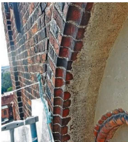
Frischer Putz am Südturm: Am 26. August hievt ein Kran die neue Konstruktion nach oben.
