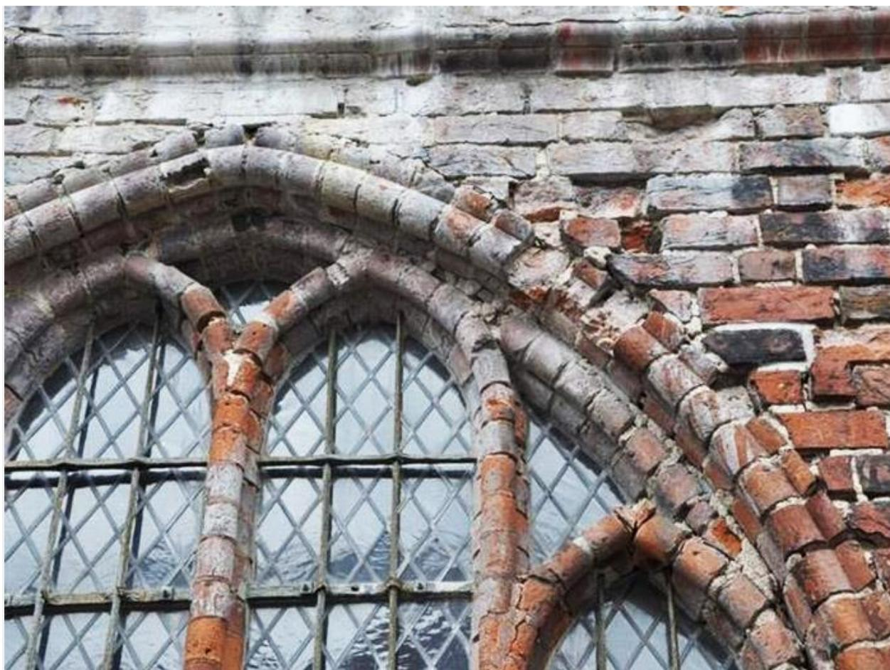
Von der Marienkirche aus sieht man an der Fassade in Fensternähe die brüchigen Stellen im Mauerwerk. Die weißen Flecken sind aus Feuchte resultierende Kalk-Ausblühungen. Foto: N. Knappe
