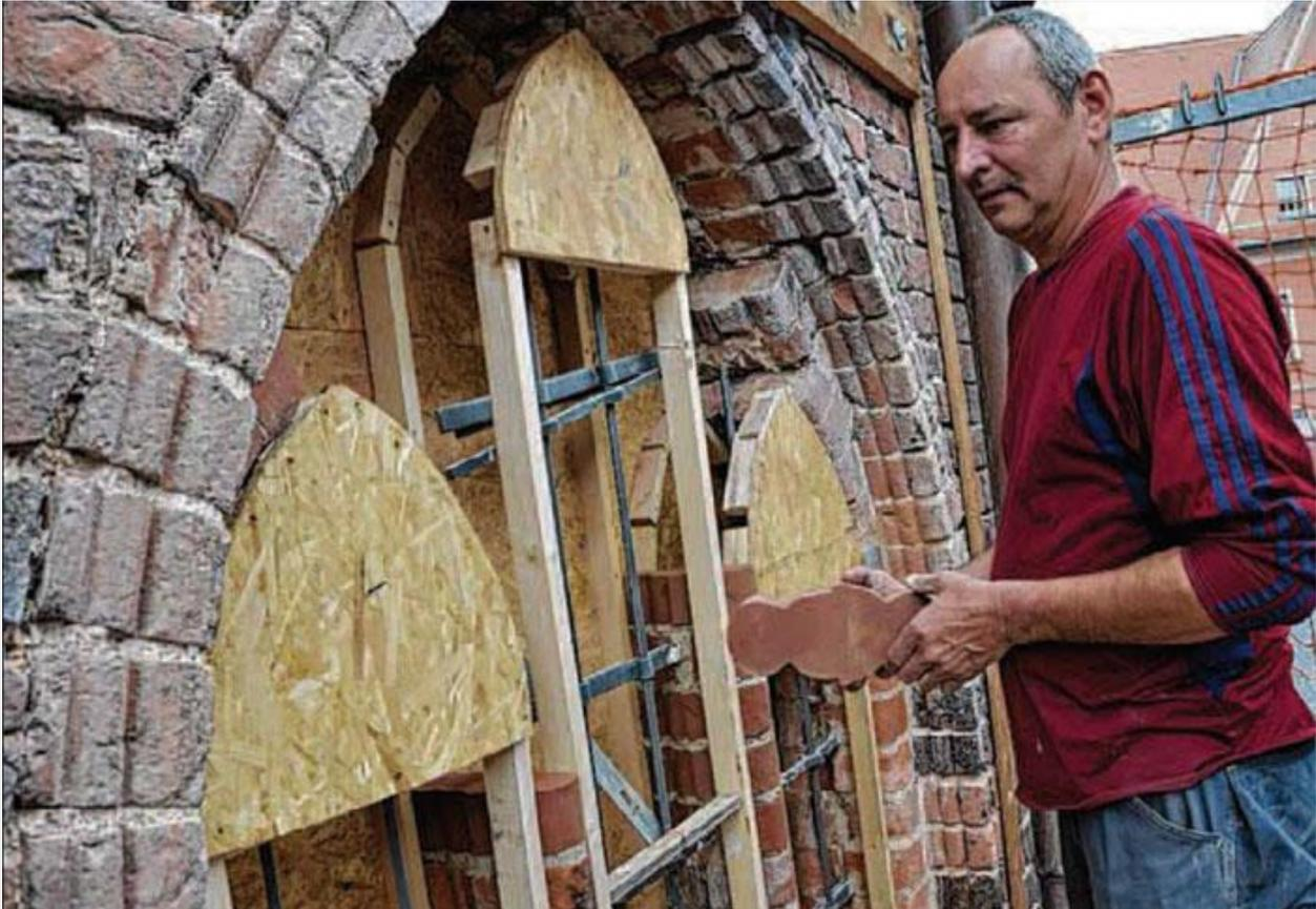
**Klaus Glauer, erfahren in Backsteinsanierung, mit einem der extra angefertigten Formziegelsteine, die an den Fenstern benötigt werden. Foto: Nora Knappe**
