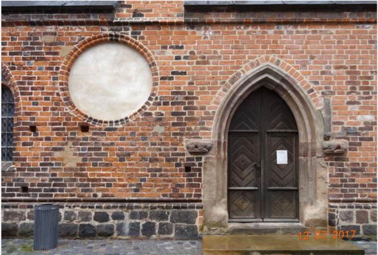
Mauerwerkssanierung links des Löwenportals.
