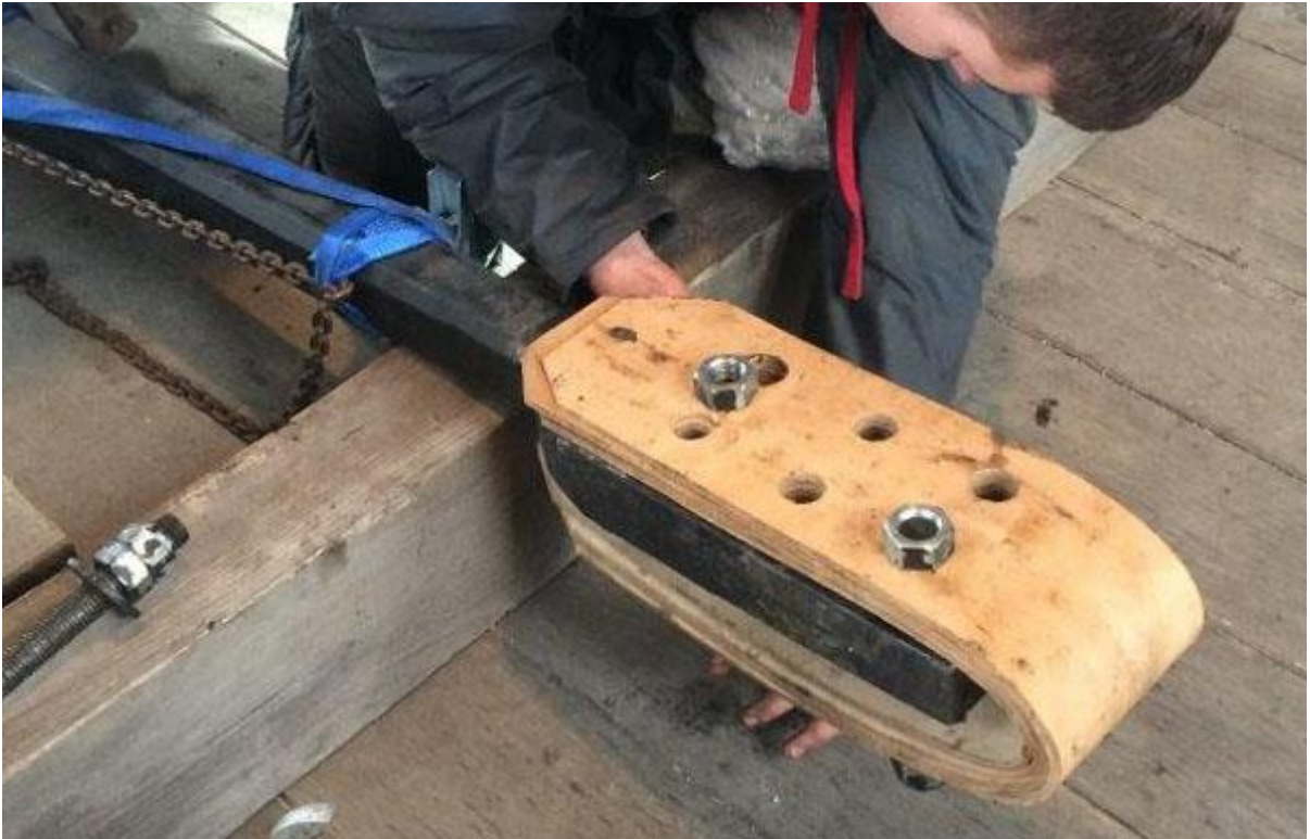
Fixierung am Klöppelblatt zur Verklebung der Lederlagen.
